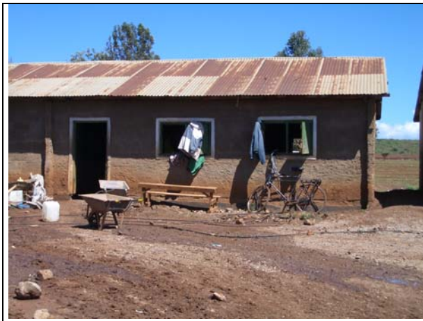
Het nieuwe kleuterlokaal in aanbouw
